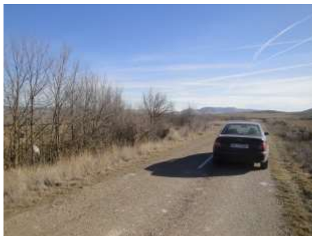
Llegada Tramo C. Punto Km. 1,540
