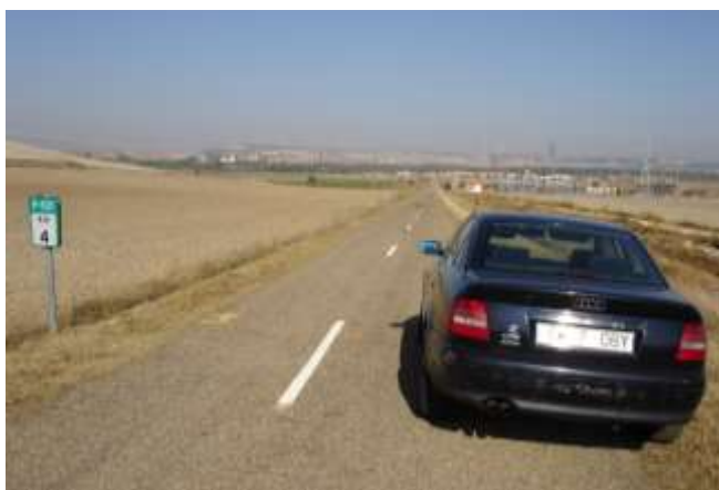
Llegada Tramo D. Km. 4,00
