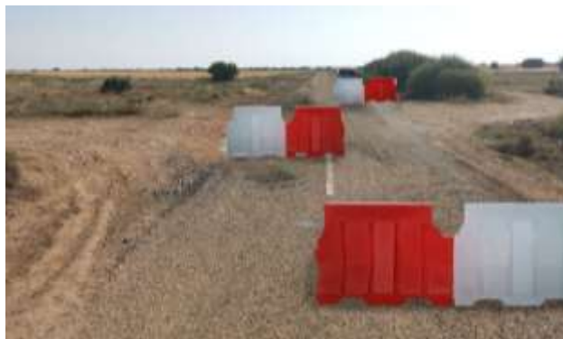
Chicane. Punto Km. 5,540 de Carretera (Punto Km 3,700 de Tramo) (El sentido de la chicane será el marcado en el asfalto)
