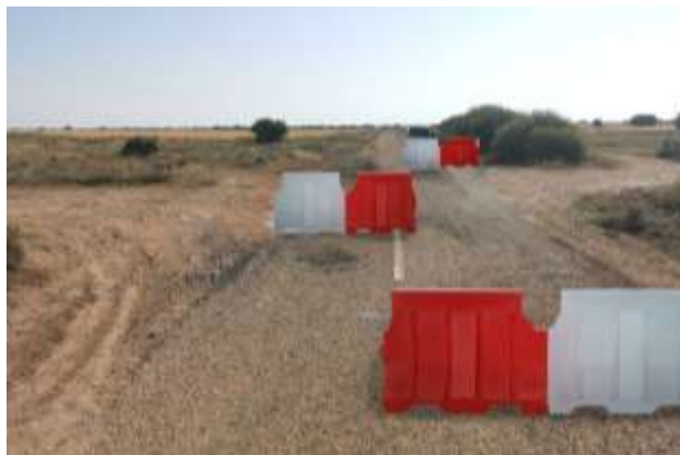
Chicane. Punto Km. 5,540 de Carretera (Punto Km 3,700 de Tramo)
