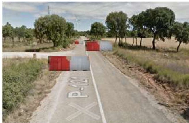
Chicane. Punto Km. 11,400 de Carretera (Punto Km 2,600 de Tramo)
