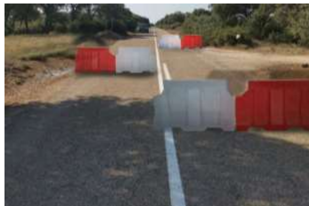
Chicane. Punto Km. 11,400 de Carretera (Punto Km 7,400 de Tramo)
